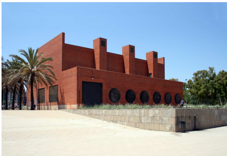
Fotografia de l'edifici de l'estació de bombament Font: Barcelona Regional
