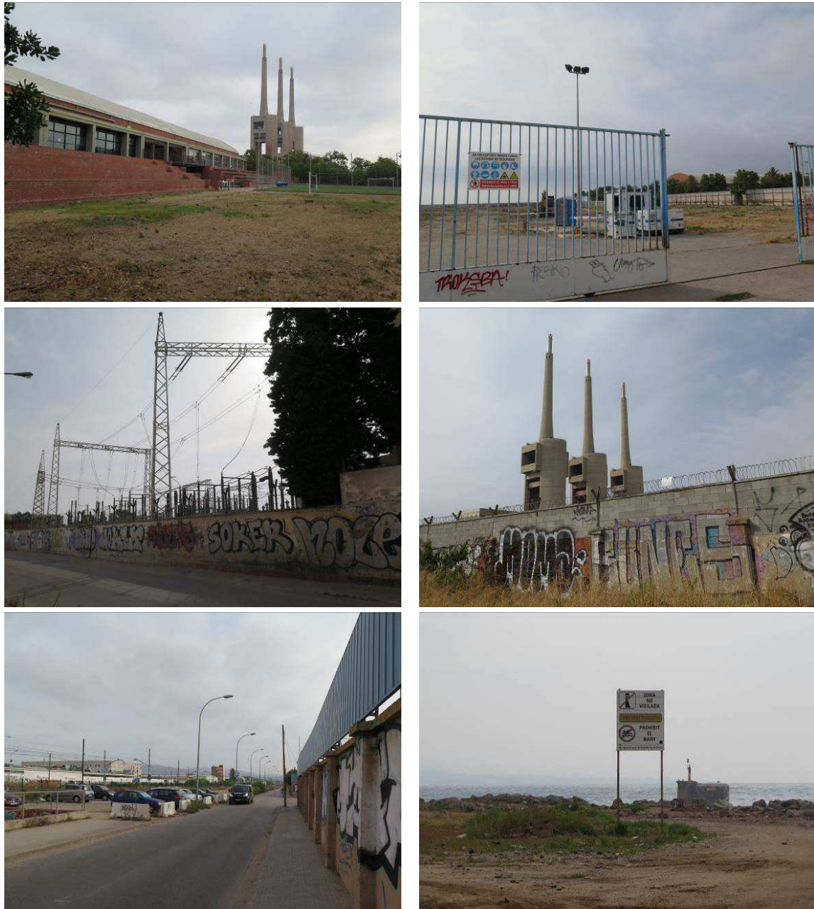
Figura 4.15. Bona part de l'àmbit es caracteritza –més enllà de la presència singular de les Tres Xemeneies– pels solars buits, tanques perimetrals amb grafit i altres elements antròpics que es mantenen –com la subestació elèctrica o el col·lector de Llevant– després del desmantellament de les activitats industrials.
