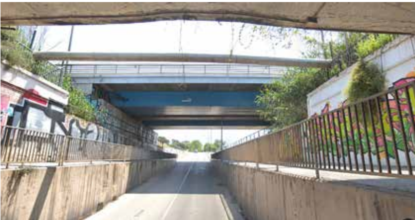
Imatges estat actual pas carrer Olímpic.
