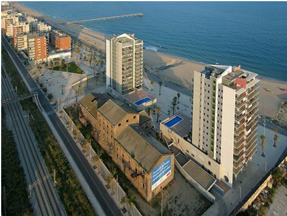
Antiga fàbrica CACI a Badalona sense ús i envoltada d'edificis de gran alçada
